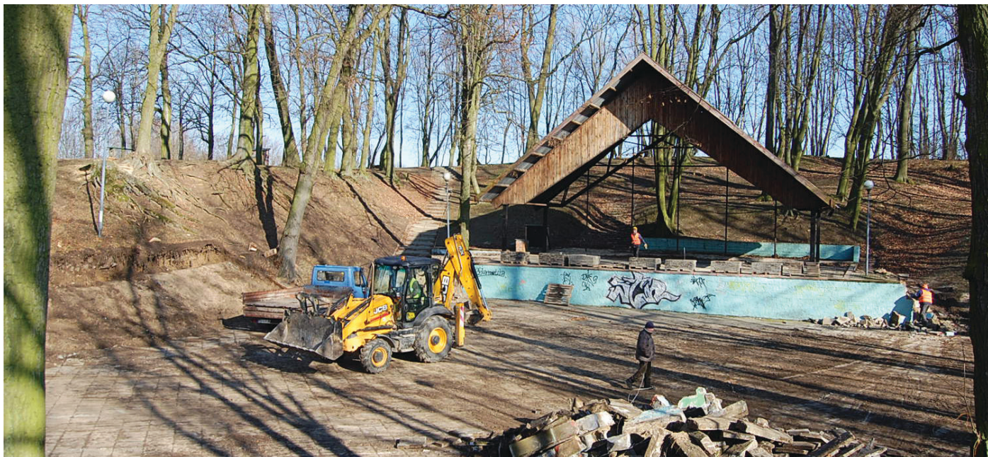
17 lutego 2016, plac budowy. Prace rozbiórkowe idą pełną parą.
