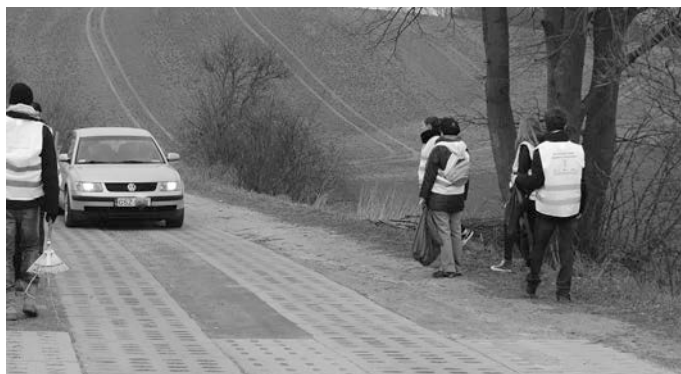
Kilka lat eksploatacji a drogi gminne z płytami jumbo mają się dobrze.
